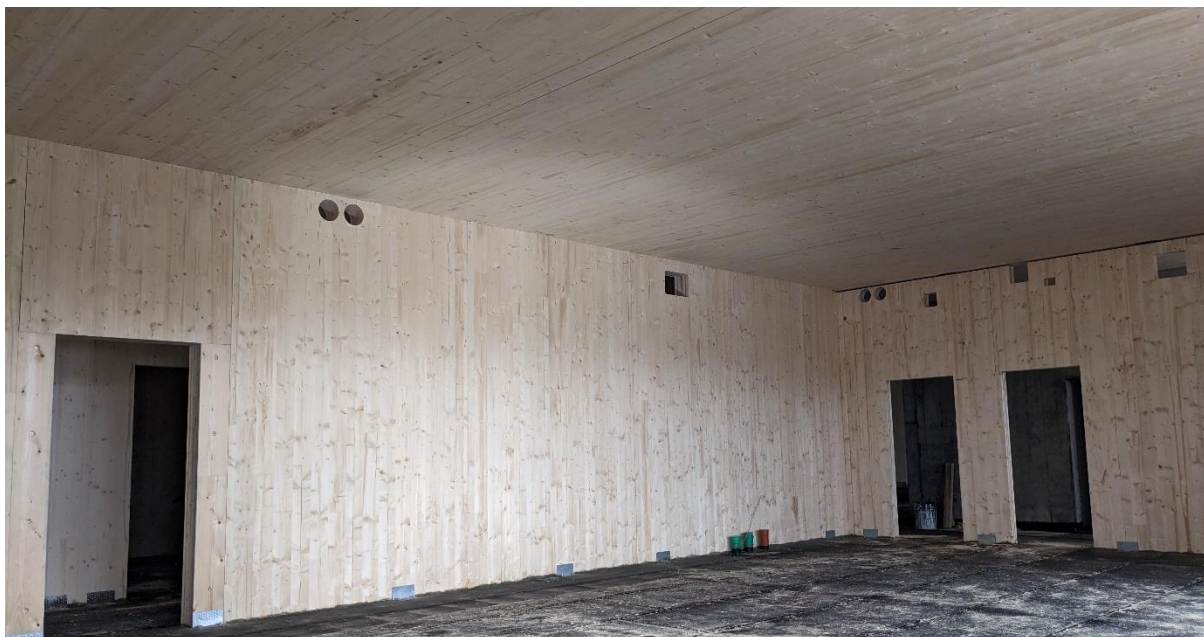
Abbildung 30: Brettsperrholz-Wandscheiben beim Neubau Grundschule Raunheim, TWP: Fast+Epp
