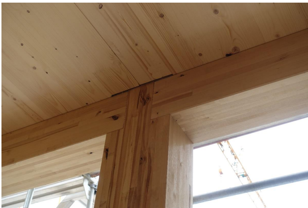
Abbildung 21: Ausgeklinkte Stütze (Neubau Kreisverwaltung Ingelheim, TWP: Fast+Epp)
