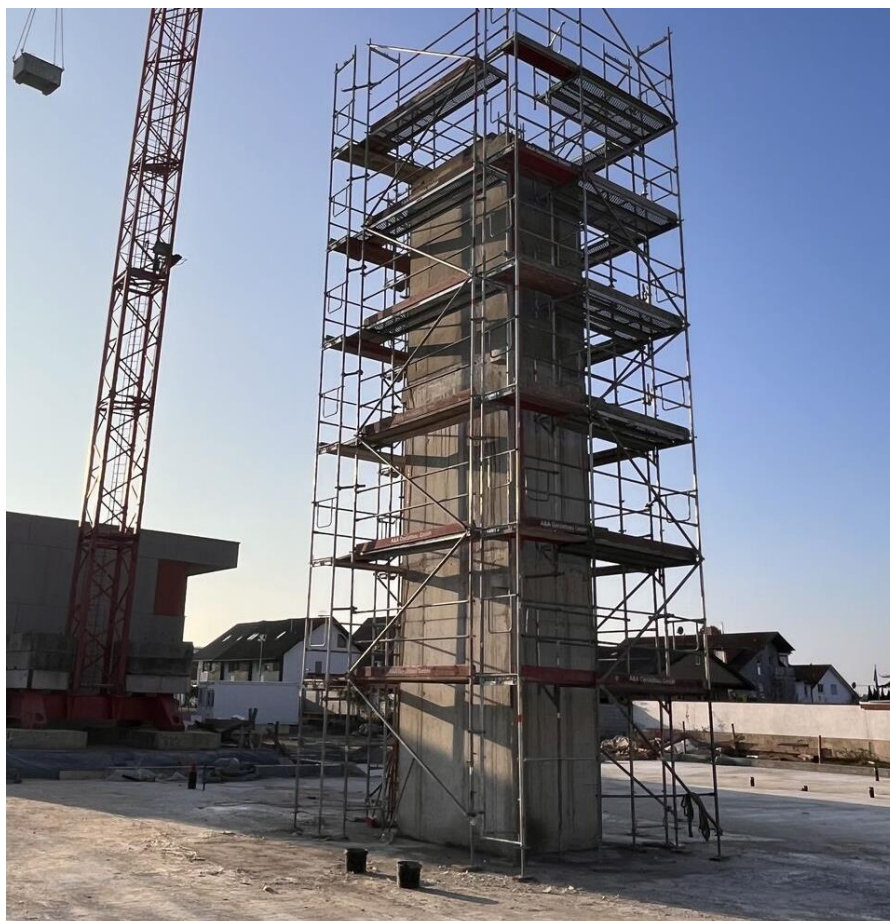
Abbildung 29: Freistehender Stahlbetonkern (Astrid-Lindgren-Schule Weiterstadt, TWP: Fast+Epp)
