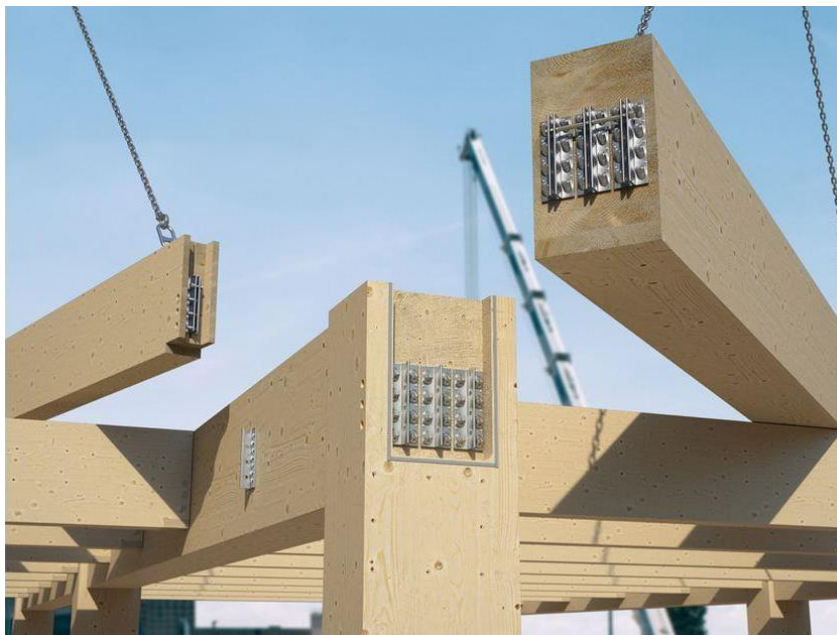
Abbildung 22: Balkenträger als Balken-Stützen-Verbindung [52]
