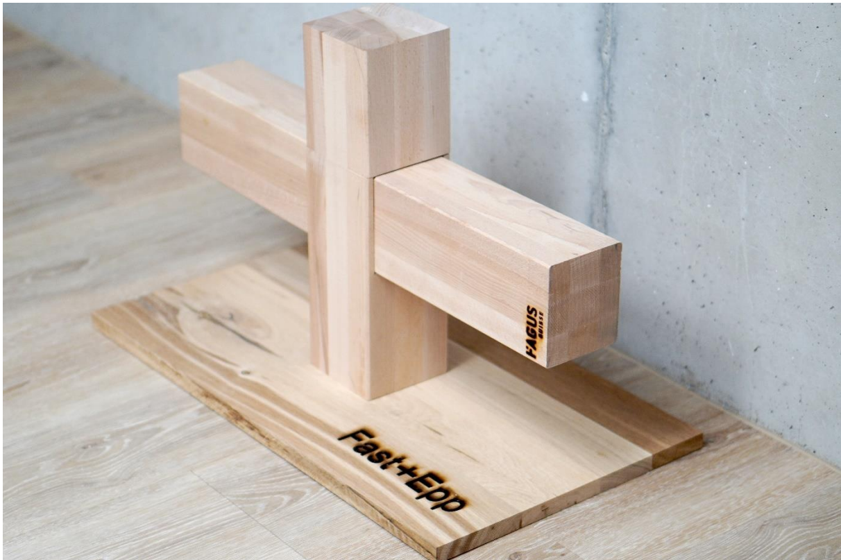
Abbildung 75: Modell des Stützenknotens Konzept 1
