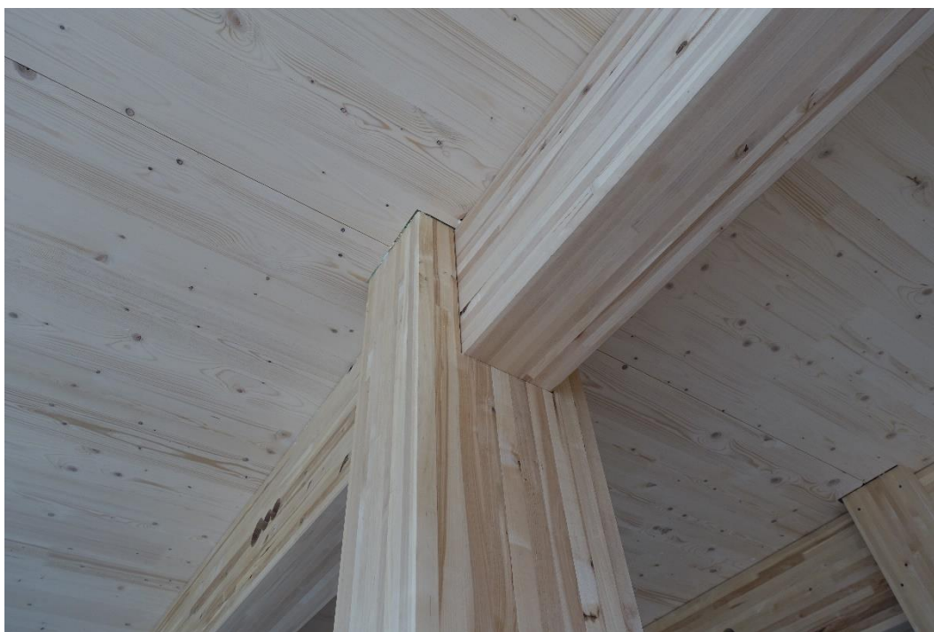
Abbildung 20: Gabelstütze (Neubau Kreisverwaltung Ingelheim, TWP: Fast+Epp)
