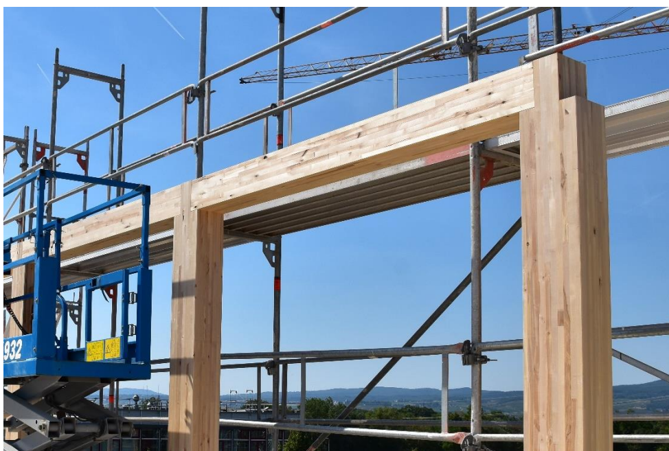
Abbildung 19: Unterzug auf ausgeklinkten Stützen (Neubau Kreisverwaltung Ingelheim, TWP: Fast+Epp)
