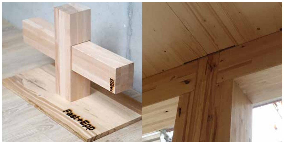
Abbildung 14: Modell des Stützenknotens mit Unterzügen (links) und ausgeführte Ausgeklinte Stütze (Neubau Kreisverwaltung Ingelheim, TWP: Fast+Epp) (rechts)
