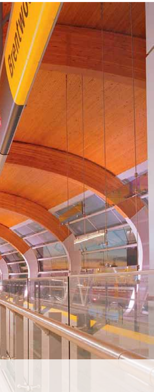
In einigen Bereichen ist die Tragkonstruktion komplett der Witterung ausgesetzt. Dort setzten die Verantwortlichen auf Stahlteile. Die Konsequenz in Sachen Holzschutz zahlt sich nach nunmehr 15 Jahren Standzeit aus.
