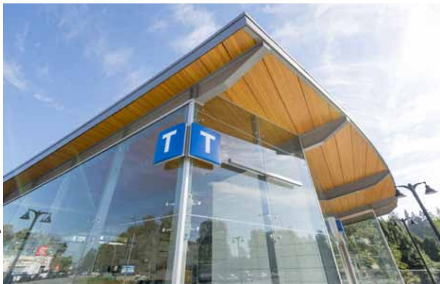
Die „Familienmitglieder“ der Evergreen Extension heißen Moody Centre, Coquitlam Central oder, wie hier im Bild, Inlet Station. Ihre Dachschalen bestehen aus stets gleich schmalen Brettstapelelementen, die vorab effizient in größeren Mengen hergestellt wurden.
