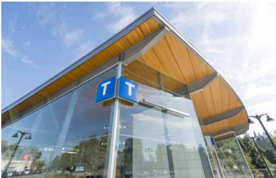
Die „Familienmitglieder“ der Evergreen Extension heißen Moody Centre, Coquitlam Central oder, wie hier im Bild, Inlet Station. Ihre Dachschalen bestehen aus stets gleich schmalen Brettstapелеlementen, die vorab effizient in größeren Mengen hergestellt wurden.
