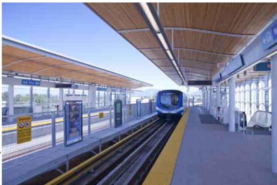
Die Station Aberdeen gehört zur Richmond-Familie. Bei der Entwicklung der Dachschale standen die Ästhetik und die Effizienz durch Modularisierung und Vorfertigung im Mittelpunkt der Überlegungen.
